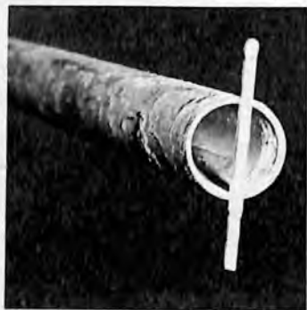
31 Der Rohrdurchmesser (mit einem Streichholz)
