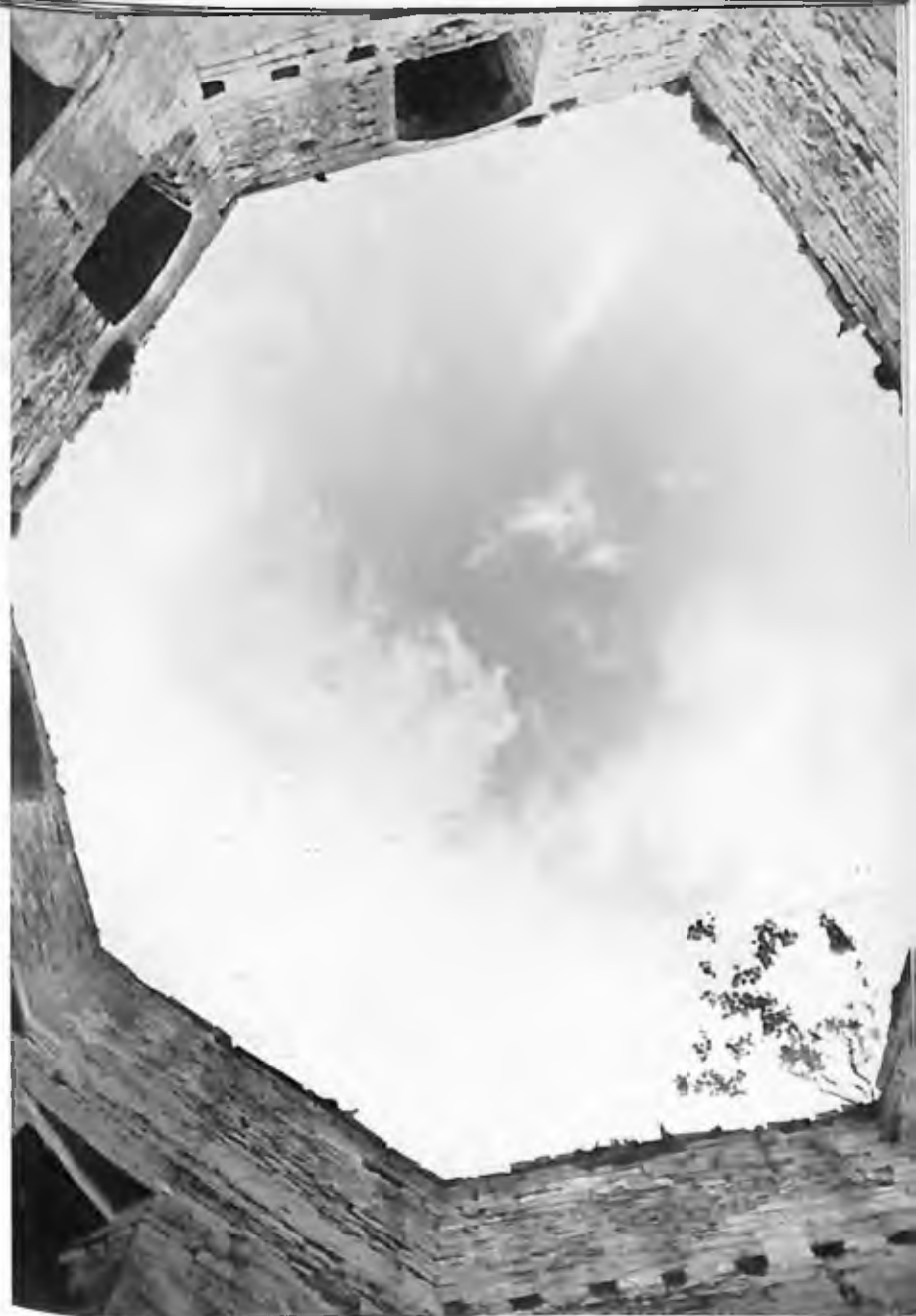
Tafel 1: Der achteckige Wehrturm. Die Templer hatten auf die oktagonale Bauweise besonderen Wert gelegt
