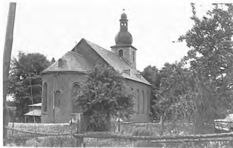
Bild 1 Die Pfarrkirche von Johannes Greber in Obergondershausen
