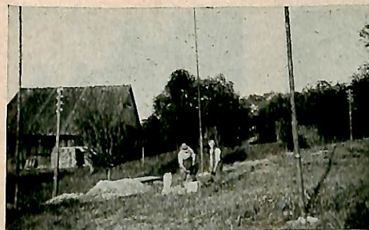
Bild 2 Beim Isolieren des Bauplatzes
